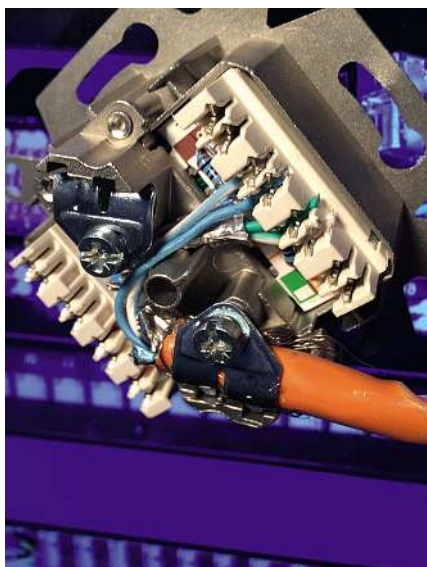
Bild 6: Das blaue Adernpärchen ist zu weit entdrillt und die Schirmfolie fehlt
